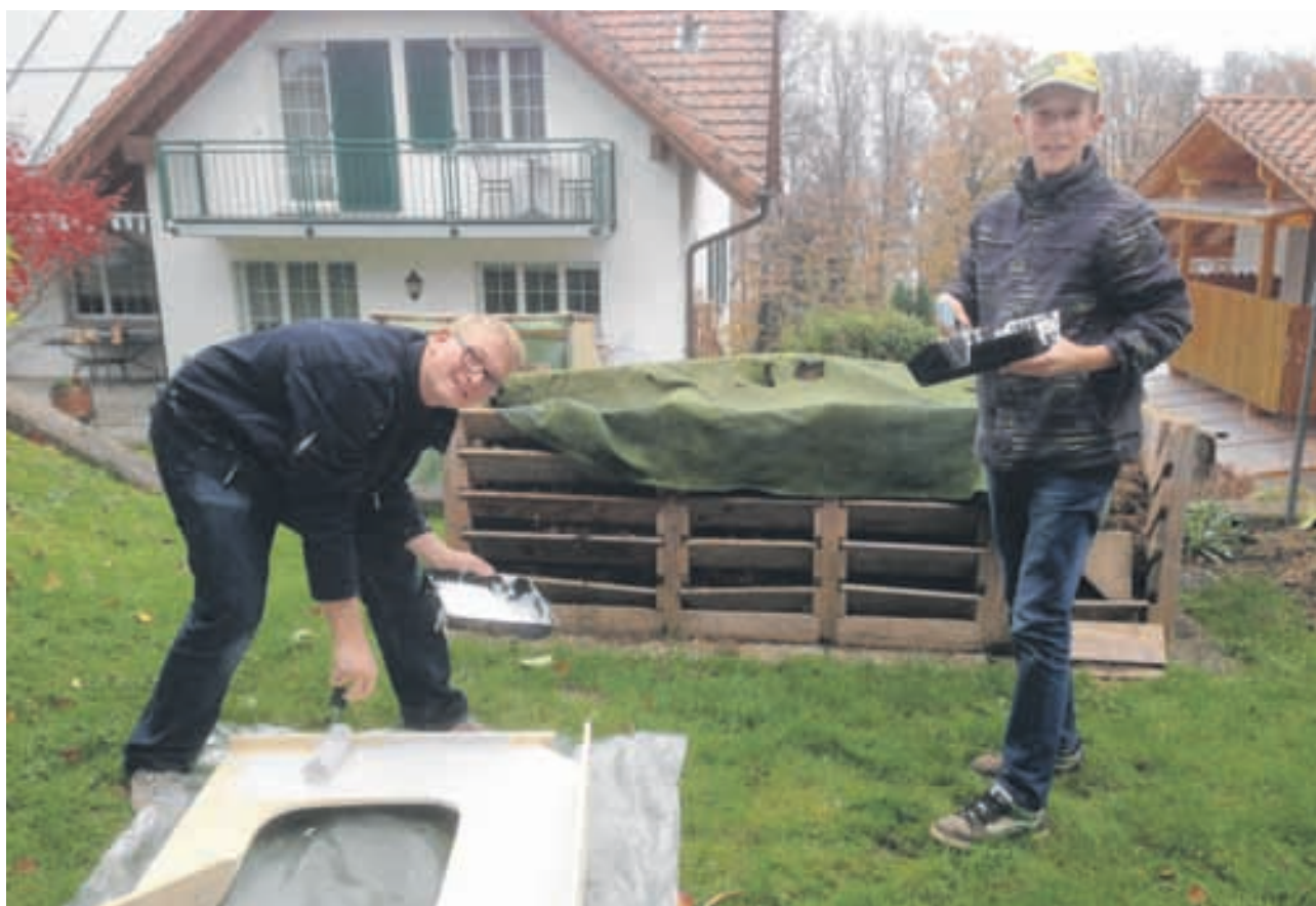
Zwei junge Burschen helfen beim Bau der neuen Krippe in Feusisberg mit.
